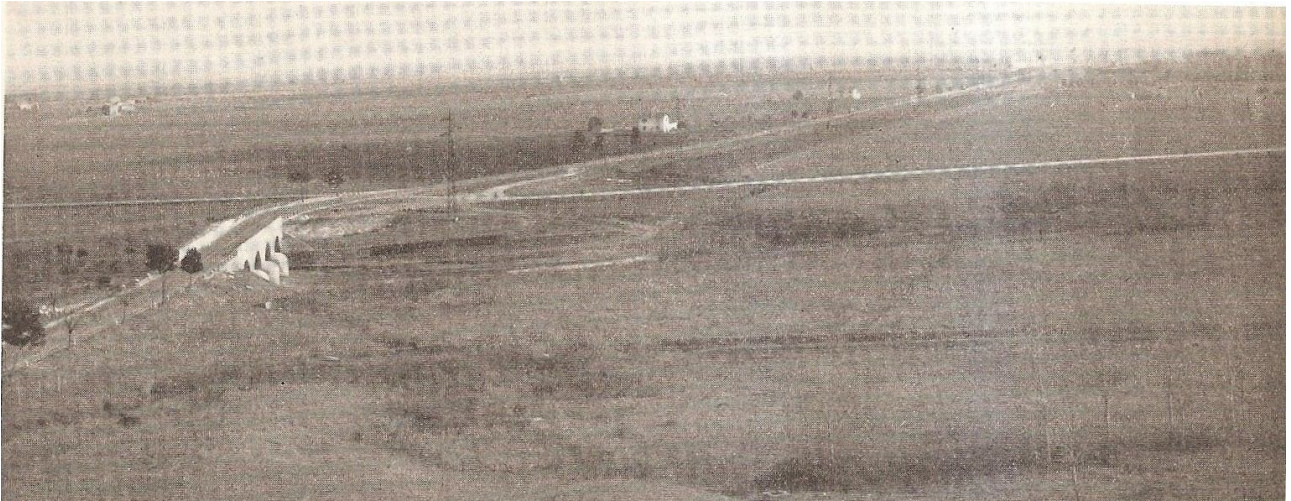
(Ponte sul torrente Cervaro). I ponti, in pietra o in cemento, hanno una loro snella estetica funzionale che ne promette anche all'occhio la assoluta solidità
